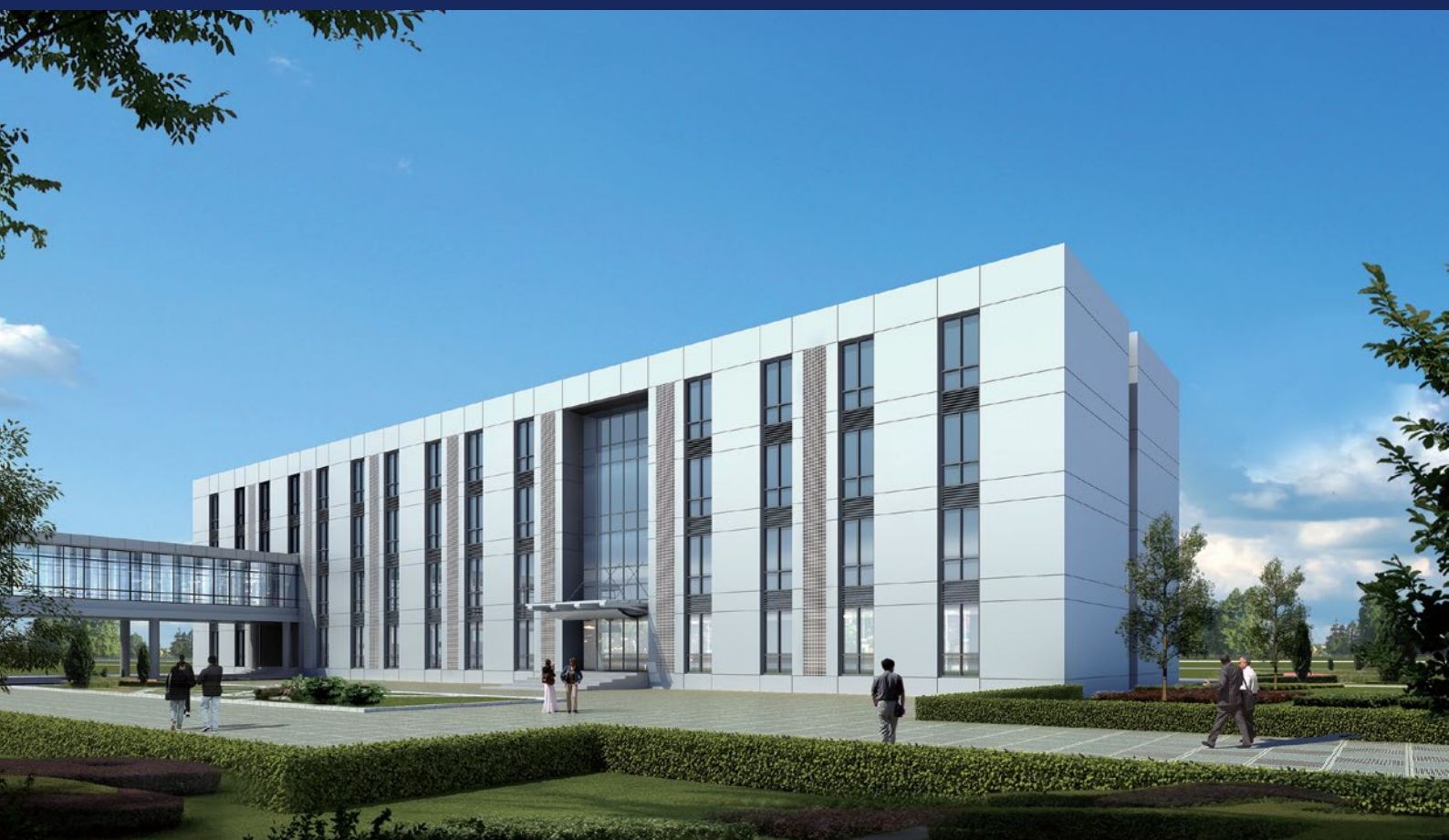
安徽智飞龙科马生物制药有限公司生物制药产业园一期项目
