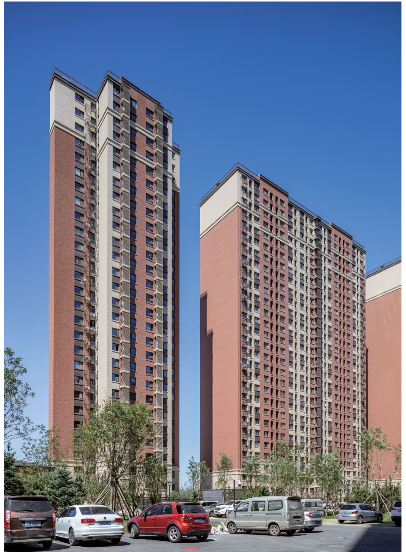
5#自住房及3#自住房南侧实景照片
