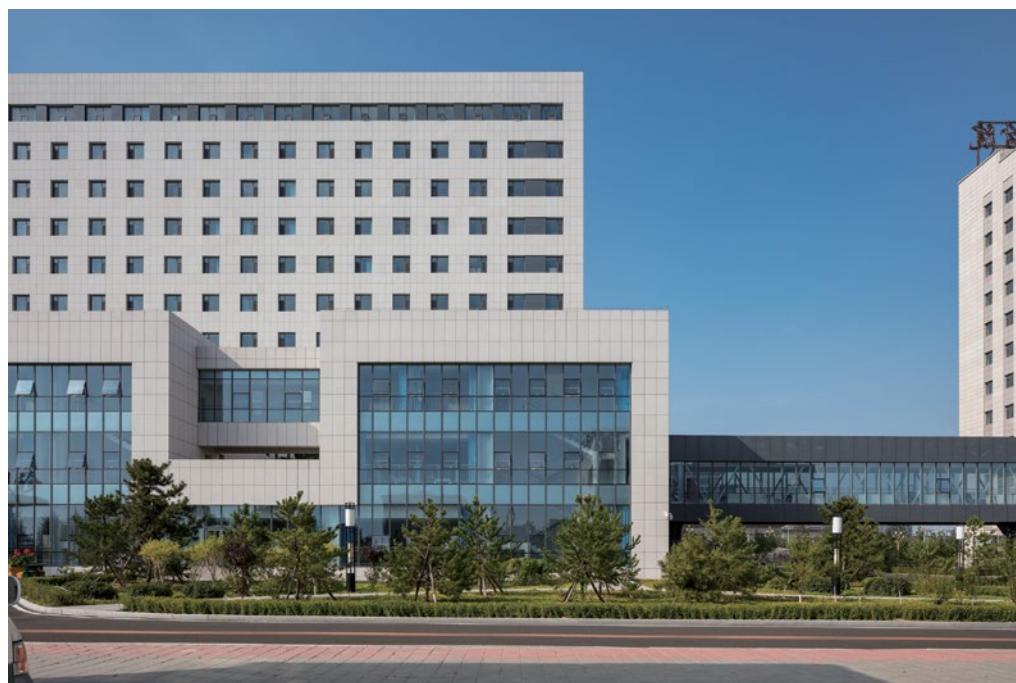
新楼与原住院楼连廊
