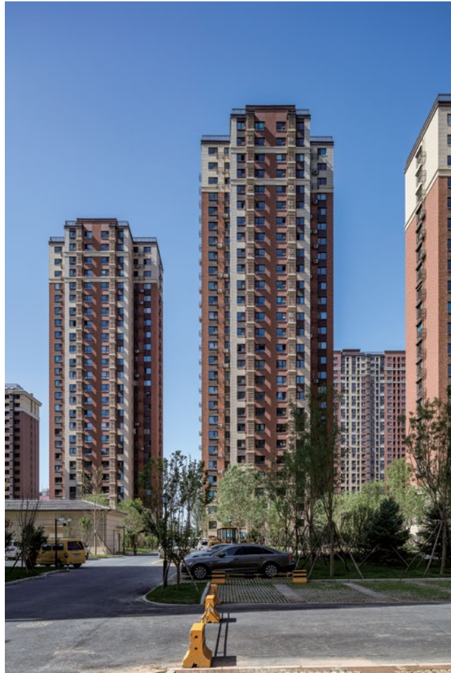
自住房南侧实景照片
