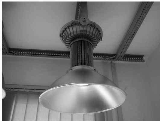
图5 散热结构B
